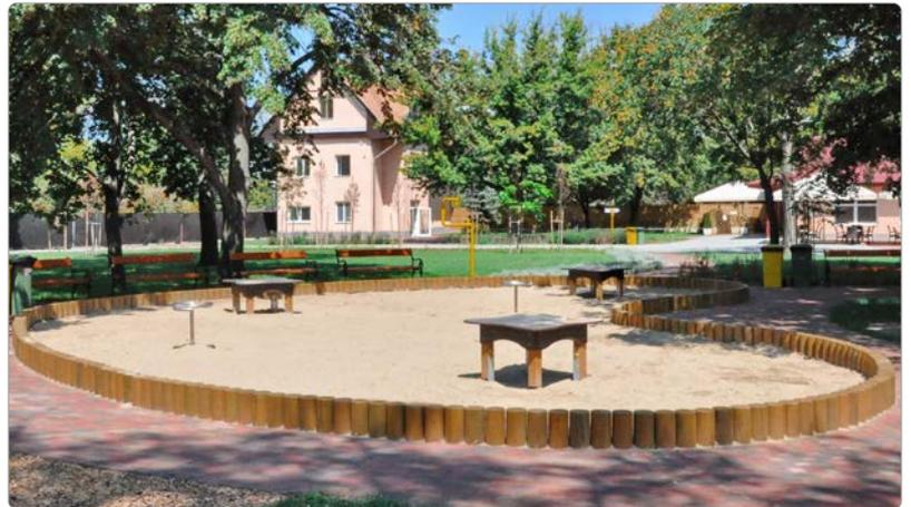
Beschreibung (Beispiel): Palisaden Ø 12 cm mit Kern, 75 cm lang, einseitig abgefast, in schmaler Künette, stehend, Mann an Mann versetzt und beiderseits mit Stampfbeton fixiert. Eingrabetiefe 0,40 m, Sichthöhe über Umgebungsterrain 0,35 m. Fundamente: Palisaden mit Beton C16/20 beiderseits abgeschragt, fixieren Gewicht: je nach Palisadenstärke
